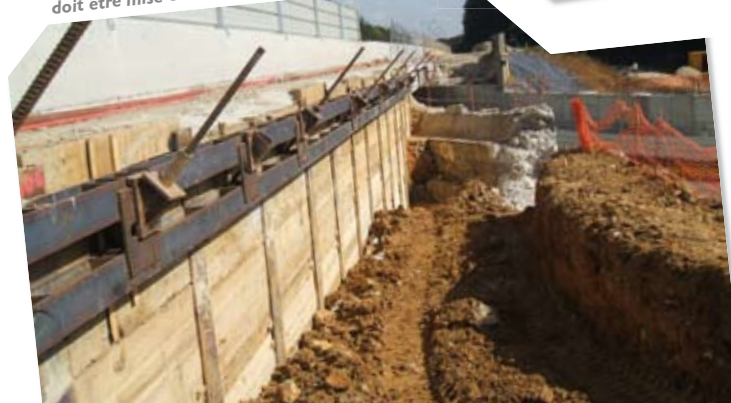
Démolition au brise-roche des entretoises
