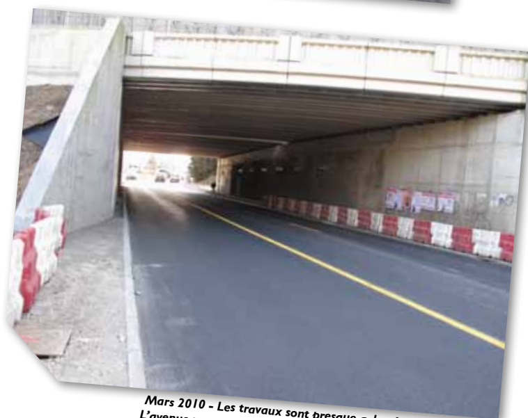
Le piétonnier en cours de nettoyage et de remise en état. L'éclairage le rendra encore plus pratique.
