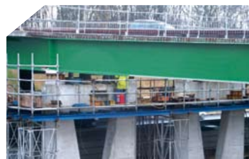
Moment délicat de la descente du tablier sur ses appuis définitifs
