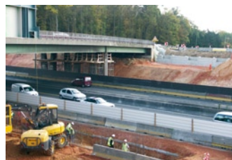
Piles en construction et culée Sud, objectif à atteindre
