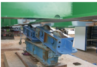
Ce système de galets permet de supporter et faire glisser la structure du tablier
