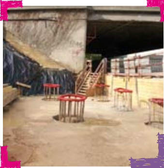
La double rangée de pieux est prête à recevoir les semelles des extensions des culées.
