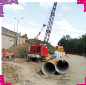
Préparation : les tubes métalliques vont être enfoncés dans le sol.
