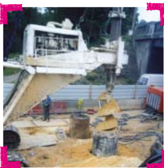
Le puits est foré, l'intérieur du tube est vidé de ses matériaux.
