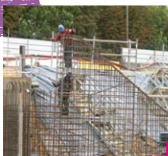
Préparation : le ferrillage va donner sa résistance au béton
