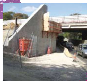
RD 321 - Culée sud ouest. La culée est prolongée d'un mur en retour pour soutenir le talus
