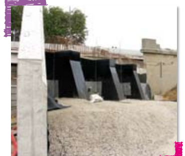
RD307- Culée sud-est. A l'arrière, la culée est renforcée par des éléments raidisseurs.
