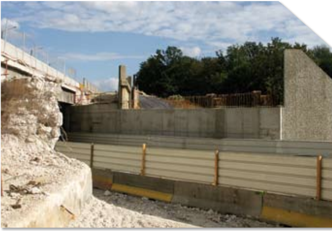
L'ancienne culée massive sera démolie. En attente du futur tablier neuf, la nouvelle culée, « côté extérieur » permet d'imaginer l'élargissement futur de l'A13 côté sud.
