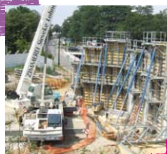
Le béton est coulé entre de grandes banches formant coffrage.
