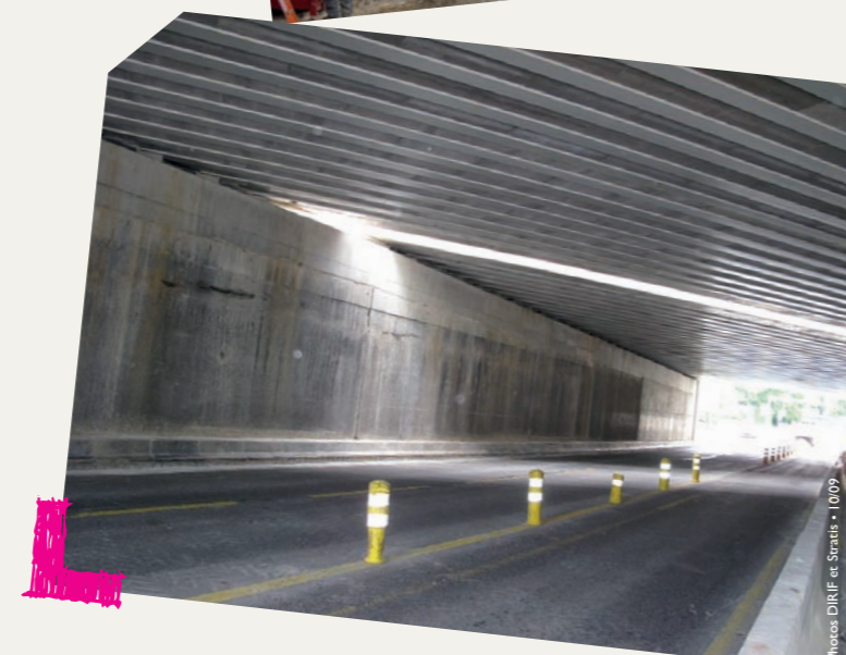
RD307 - un nouveau tablier aux nouvelles dimensions du pont.
