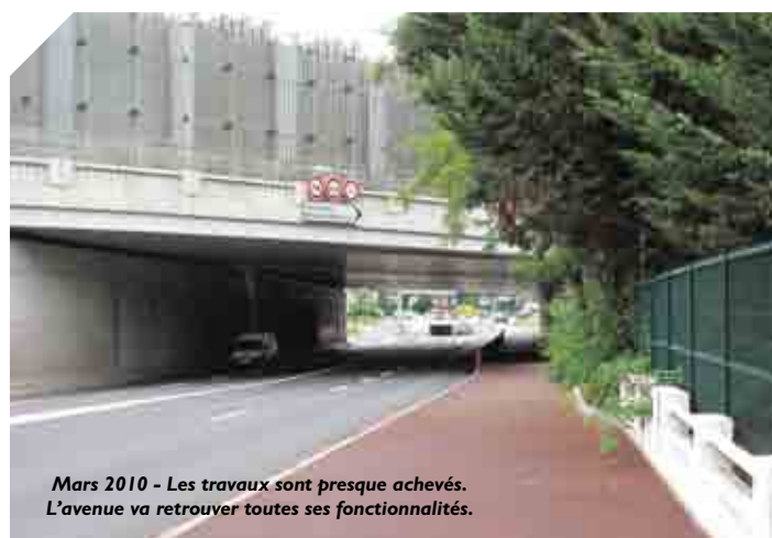
Une voie dédiée aux circulations douces permet un passage dénivelé pour piétons et cyclistes.
